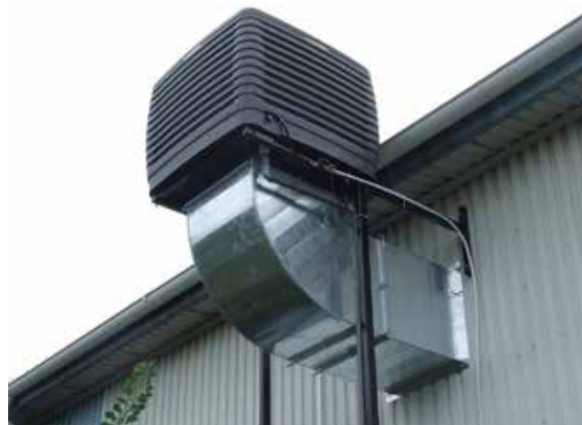
1. ábra. Direkt evaporatív léghűtő berendezés [3]
