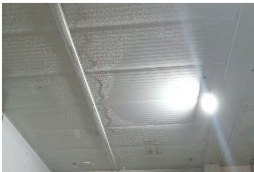
1. kép – Felületi kondenzáció a baromfi-feldolgozó hűtött munkaterében
